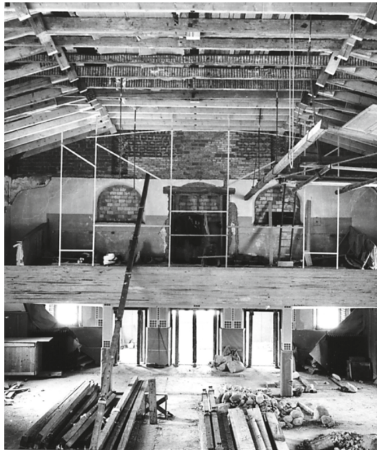
Kirche Pfäffikon während des Umbaus 1947/1948. Blick Richtung Empore. Die neue Dachkonstruktion mit dem Tonnendach ist bereits erkennbar. (Foto: Paul Stutz, 1947)
