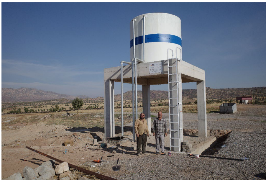
Von CAPNI finanzierter Wasserturm in Levo, Zaxo District/ Gouvernement Duhok.
